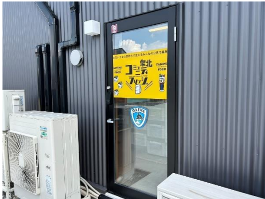
写真9 コミュニティフリッジ外観
